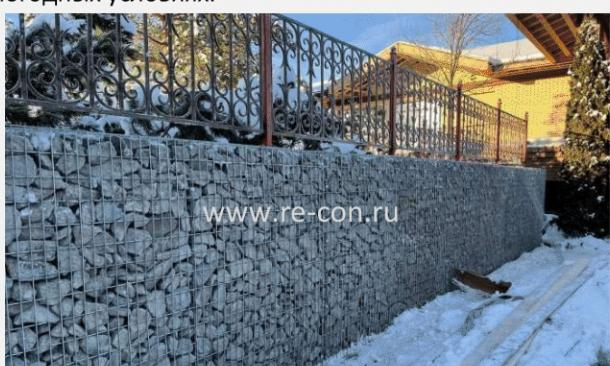
**3. Дренаж не требуется:** в отличие от бетона, сварные габионы в дополнительном дренаже не нуждаются, т.к. конструкция из сварной сетки и камней является полностью дренируемой и водопроницаемой.
