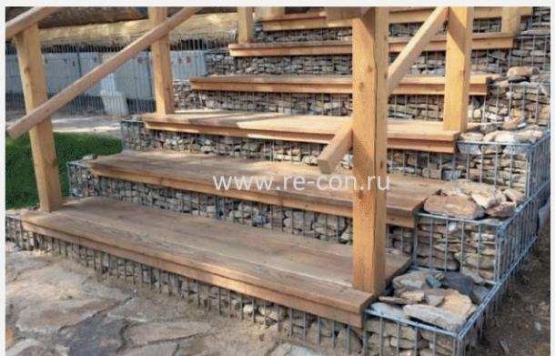
**4. Точная геометрия:** с помощью сварных габионных конструкций можно выполнить любую геометрию
