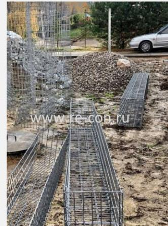
Сварные габионы представляют собой объемные сетчатые изделия, собираемые в прямоугольные формы из сетчатых панелей. Основой сварного габиона служит сварная сетка с ровными прямоугольными клетками.
