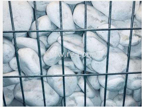
**8. Шумозащита:** заполненные камнем сварные габионные конструкции обладают превосходным звукопоглощением, что особенно оправдано при строительстве заборов (перегородок) из габионов
