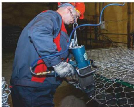
**Монтаж габионных конструкций** включает в себя: распаковку и раскладку конструкций; сборку и установку диафрагм; расстановку конструкций в проектное положение; связывание их между собой; вытягивание и заполнение камнем.
