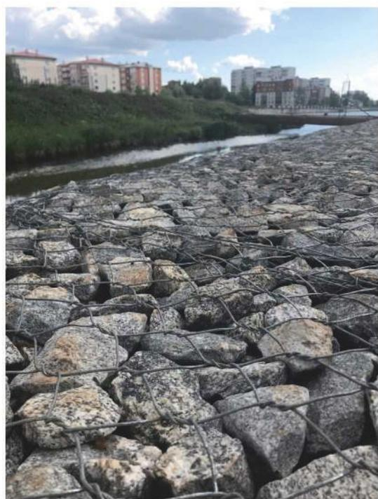
Помогают сформировать ландшафт прибрежной зоны водоема, создать террасирование склона. Они часто применяются в качестве «фундамента» для монтажа коробчатых габионов, при этом выступают в роли защитного фартука - благодаря им основания конструкций не размываются.
