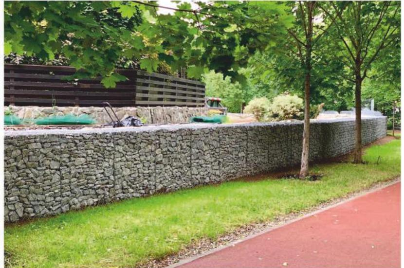
Применяются для строительства подпорных стенок и заборов, берегоукрепления, облицовки плотин и укрепления дамб, террасирования местности.
